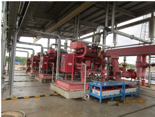
รูปที่ 59 ปัมพ์สูบน้ำดับเพลิง
