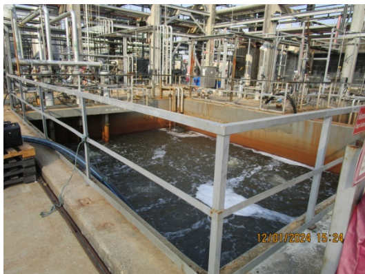
รูปที่ 95 ถังรวบรวมน้ำก่อนเข้า Aeration Tank (Bio Transfer Tank)
