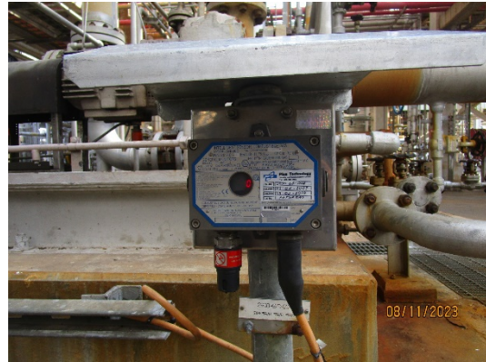
รูปที่ 54 Gas Detector
