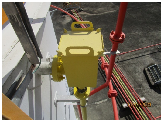
รูปที่ 82 Foam Chamber
