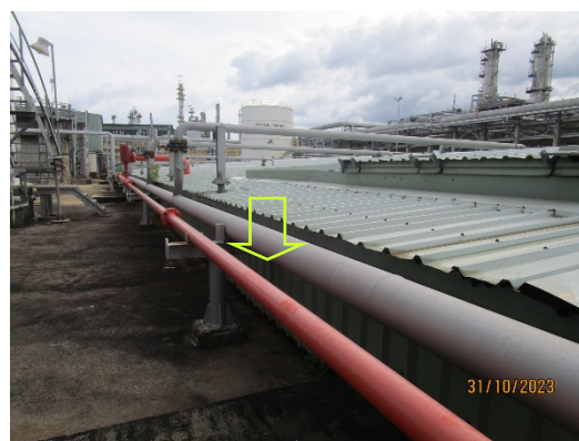
รูปที่ 32 ท่อรวบรวมไอไฮโดรคาร์บอนจาก Holding Basin ไปยัง Vapor Adsorber
