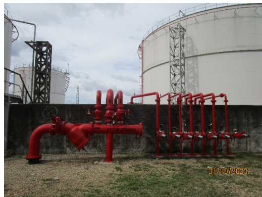
รูปที่ 62 ระบบฉีดพรมน้ำบริเวณด้านบนและรอบถังเก็บ
