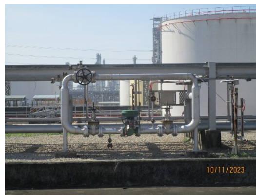
รูปที่ 89 วาล์วตัดแยกระบบ (Isolate Valve) ต้นทาง
