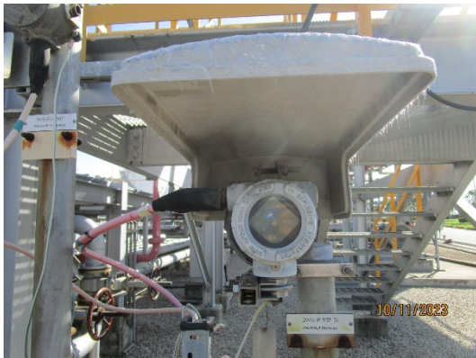
รูปที่ 86 Flow meter วัดอัตราการไหลของสารในท่อ
