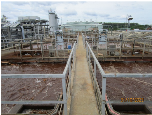
รูปที่ 19 ระบบบำบัดน้ำเสียรวมของโรงงาน แบบ Activated Sludge
