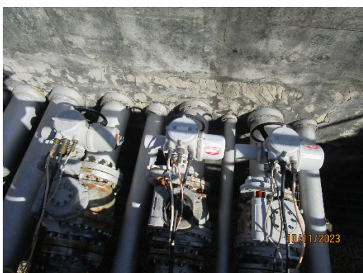
รูปที่ 90 วาล์วตัดแยกระบบ (Isolate Valve) ปลายทาง
