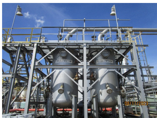
รูปที่ 33 ระบบบำบัดไอไฮโดรคาร์บอนจาก Holding Basin (Vapor Adsorber (2930-V205A/B))
