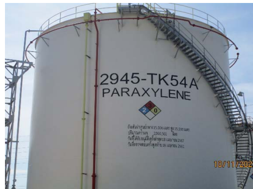
รูปที่ 8 ถังสำรองสารไฮโดรคาร์บอนทั่วไป เป็นชนิด CRN
