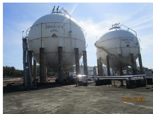
รูปที่ 73 ถังทรงกลมสำหรับเก็บ LPG
