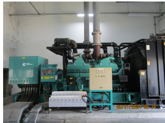
รูปที่ 75 ระบบไฟฟ้าสำรอง (Diesel Generator)
