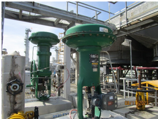
รูปที่ 49 Low Noise Valve
