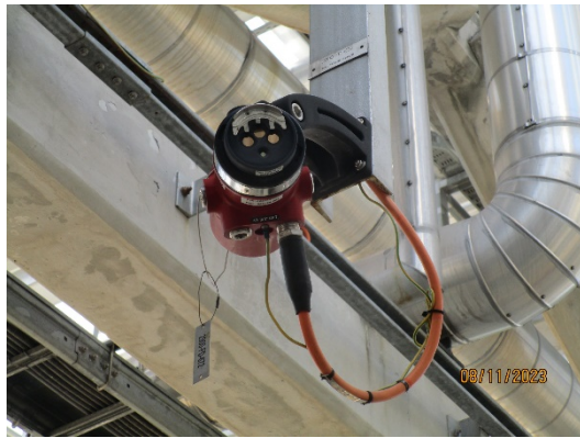
รูปที่ 53 Flame Detector
