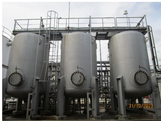
รูปที่ 26 หน่วยกำจัดสารแขวนลอย (DAF) (2930-TK23) ของ NEW ETP
