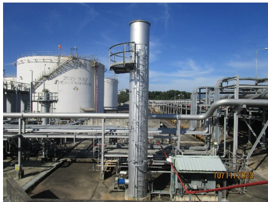
รูปที่ 13 ระบบกำจัดไอสารไฮโดรคาร์บอน จากการขนถ่ายสารไฮโดรคาร์บอนทางรถบรรทุก
