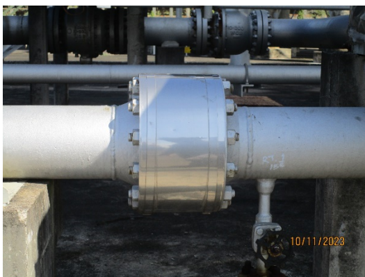
รูปที่ 88 Check Valve เพื่อป้องกันการไหลย้อนกลับ ออกจากถังรับที่ปลายทาง
