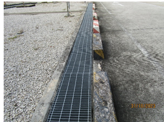
รูปที่ 14 ระบบรวบรวมน้ำไม่ปนเปื้อน (Clean Water Sewer : CWS)
