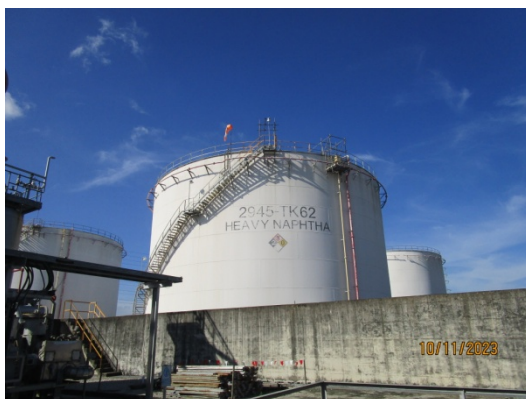
รูปที่ 72 กำแพง (Dike) ล้อมรอบถังเก็บวัตถุดิบและผลิตภัณฑ์
