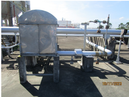
รูปที่ 92 Remote Shut-off-Value (ปลายทาง)
