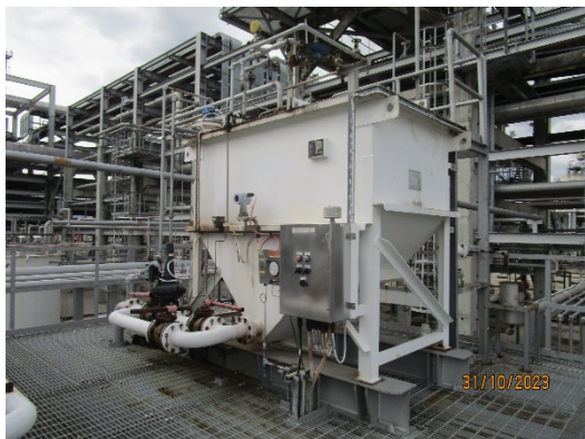
รูปที่ 23 หน่วยแยกน้ำมันออกจากน้ำ (CPI)
