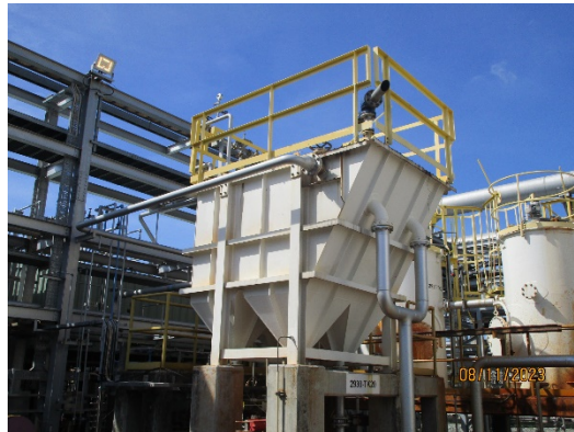
รูปที่ 24 หน่วยแยกน้ำออกจากน้ำมัน (CPI) (2930-TK20) ของ New ETP
