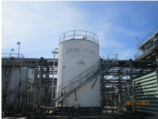
รูปที่ 17 ถังพักน้ำทิ้งปนเปื้อนปรอท (2930-TK80)
