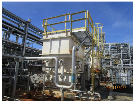
รูปที่ 26 หน่วยกำจัดสารแขวนลอย (DAF) (2930-TK23) ของ NEW ETP
