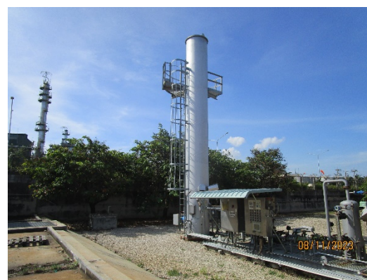
รูปที่ 34 หน่วยกำจัดไอไฮโดรคาร์บอน ในระบบบำบัดน้ำเสีย (Vapor Disposal Unit)
